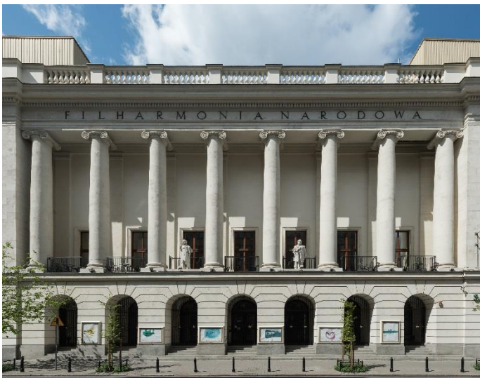
Budynek Filharmonii Narodowej przy ul. Jasnej w Warszawie
